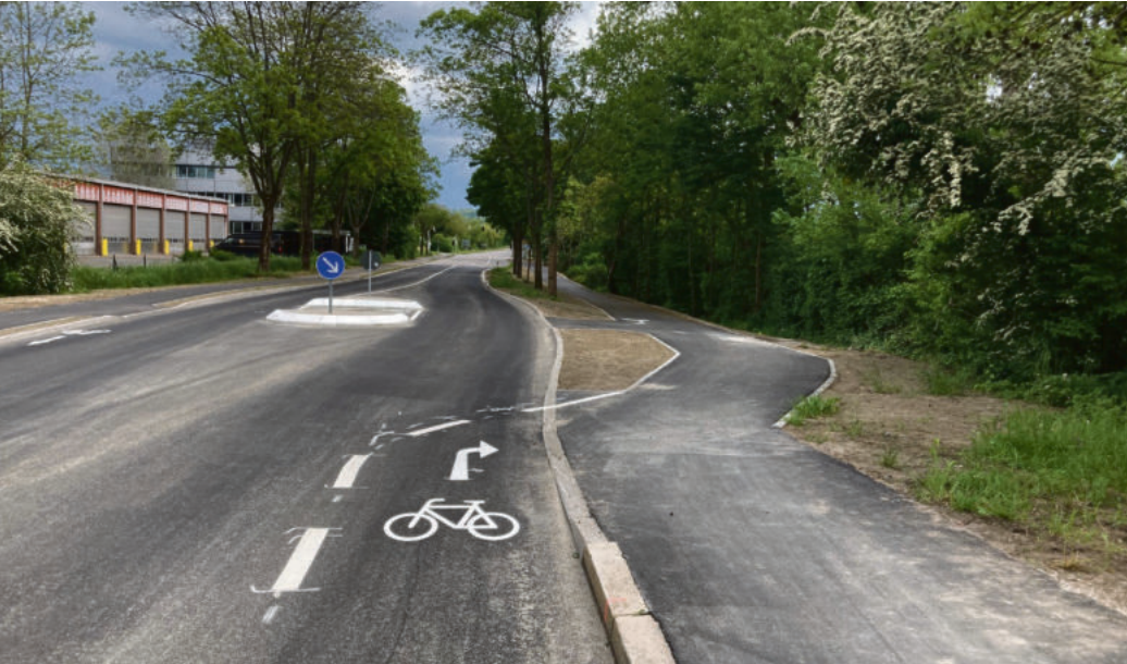
Das fertiggestellte Teilstück der Radroute 17b zwischen Hagsfeld und Grötzingen in der Brückenstraße. Foto: Stadt Karlsruhe, Tiefbauamt
