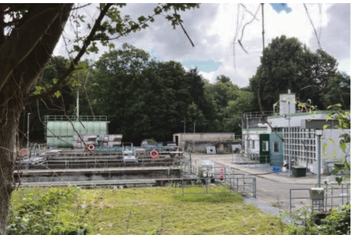
Das Klärwerk in Berghausen.
