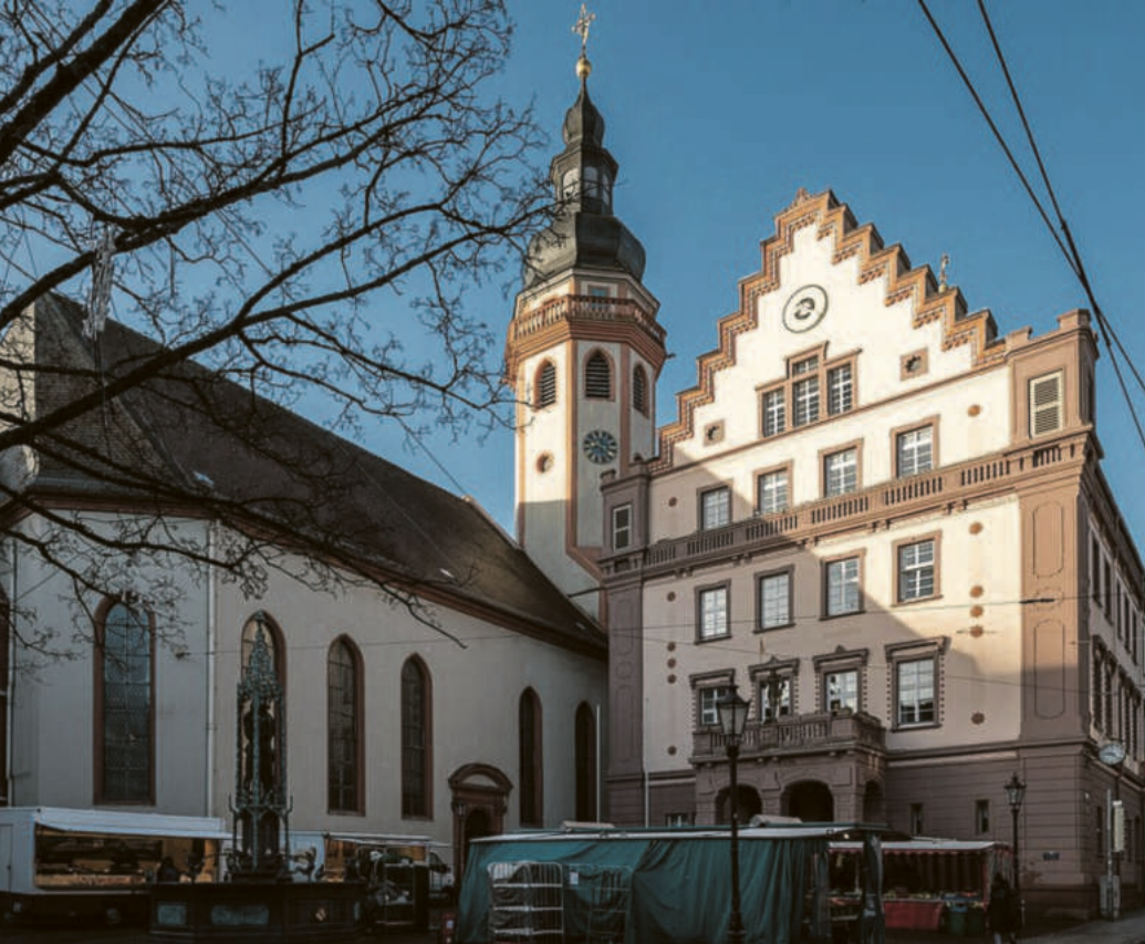
Vom 28. bis 31. Oktober schließt das Rathaus Durlach ganztägig aufgrund von Bauarbeiten. Foto: Stadt Karlsruhe, Monika Müller-Gmelin
