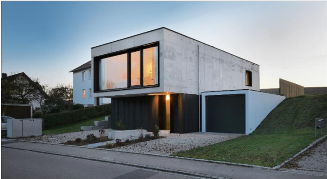
Infraleichtbeton hat einen hohen Luftanteil – und deswegen benötigen Eigenheime aus dem innovativen Baustoff keine zusätzliche Wärmedämmung für die Außenwände. Foto: Michael Christian Peters/betonbild
