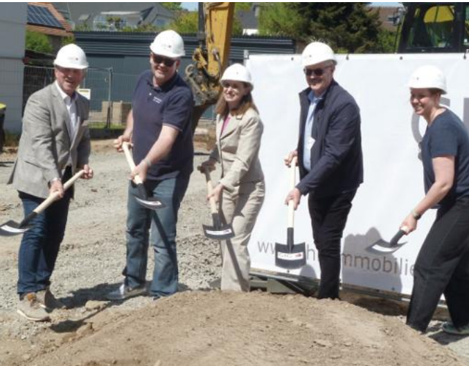
Spatenstich von links nach rechts: Klaus Göhl (GIG Geschäftsführer), Dr. Ludger Ascherl, Kerstin Tron (Ortsvorsteherin), Willy Kolarsch (GIG Geschäftsführer), Kathrin Wressnegger (Assistentin) Foto: Stefan F. Esser
