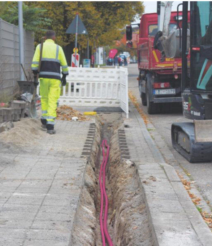
Ausgeträumt? Die Verlegung der Glasfaser lässt in Pfinztal auf sich warten. Foto: Sven Scherz-Schade
