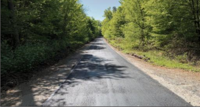
Die „Alte Ittersbacher Straße“ vor und nach der Sanierung. Fotos: Karl-Heinz Stöber
