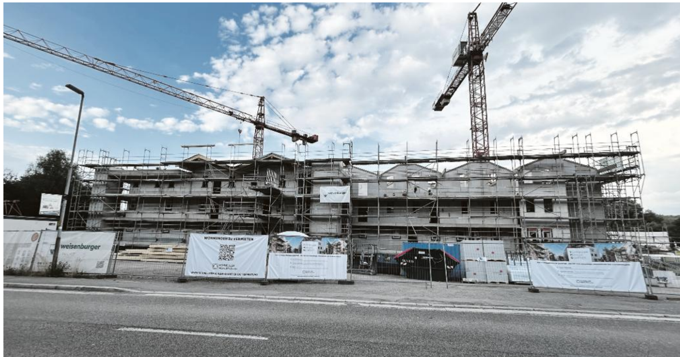
Der Baufortschritt des Projekts Schnellermühle zeigt die enormen Ausmaße der Gebäude zur Kleinsteinbacher Straße hin. Foto: Harald Ehrler.
