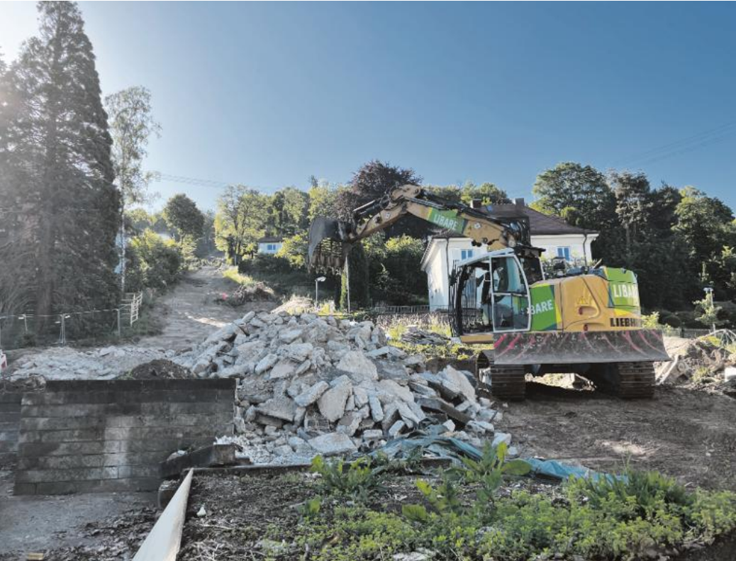
Die Turmbergbahn in Durlach wird modernisiert und bis zur Bundesstraße B3 verlängert. Der Rückbau an der alten Talstation ist abgeschlossen. Jetzt werden Leitungen am Fuße der Bergbahnstraße und im Bereich der B3 verlegt. Foto: Nicolas Lutterbach, KVV
