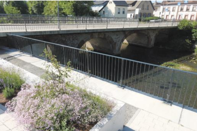
Die neuen Sitzgelegenheiten an der Pfinz laden zum Verweilen und zum Blick auf die fast 280 Jahre alte Brücke ein. Foto: Iris Treiber
