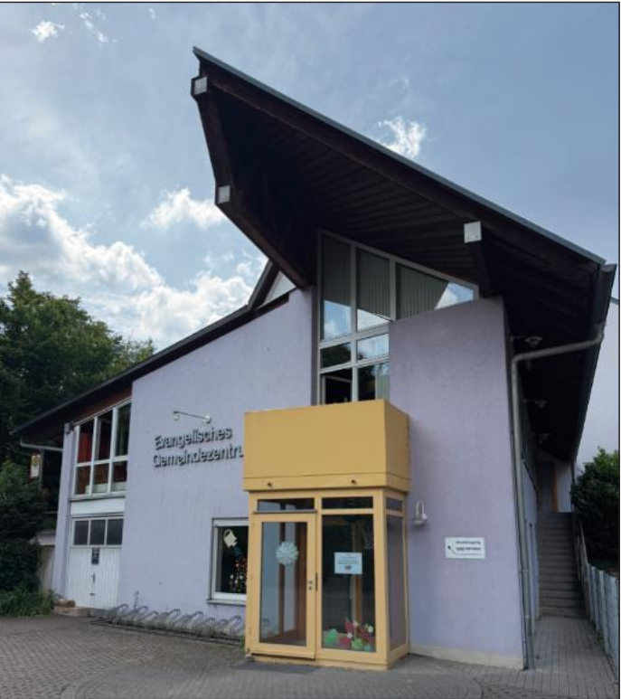
In Mutschelbach werden die Schulkinder im früheren evangelischen Gemeindehaus betreut werden. Foto: Katharina Blösch
