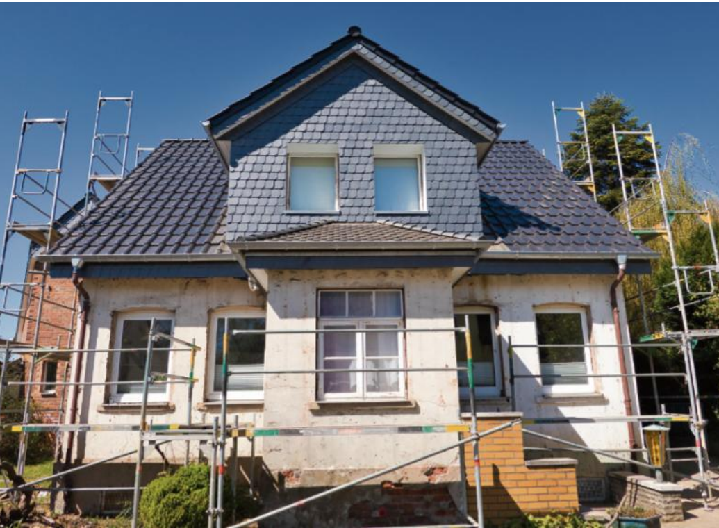
Umfassende Sanierungen zum Effizienzhaus werden weiterhin über die KfW gefördert – mit vergünstigten Kreditzinsen und Tilgungszuschüssen. Foto:FMI / Frank Oppermann – Shutterstock
