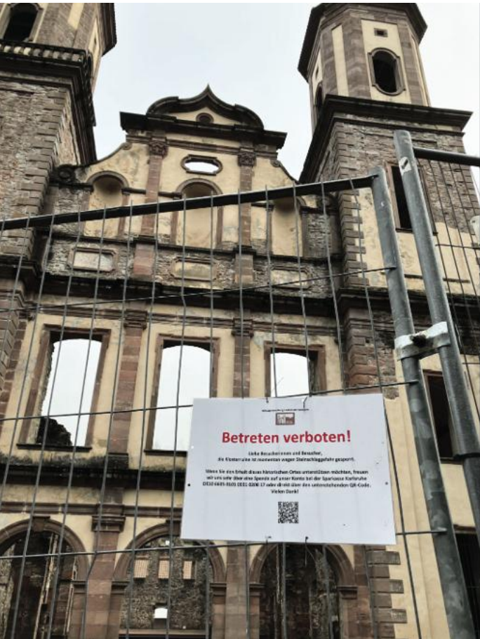
Bis Anfang September dauern die Notsicherungsmaßnahmen, um die vorübergehende Sperrung des Klostergeländes wieder aufheben zu können.
