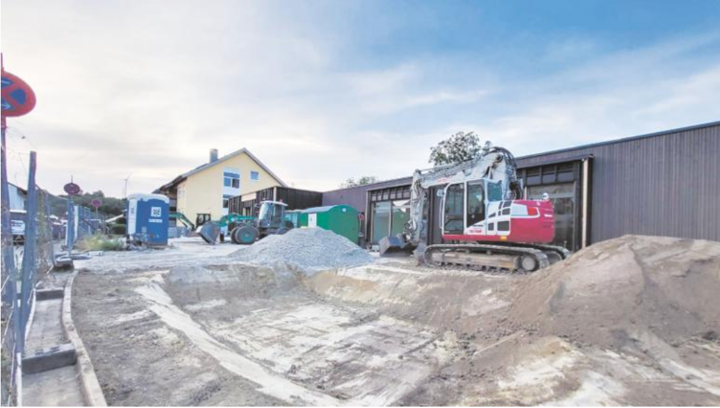
Unser Foto zeigt die Baumaßnahme an der Kita Louise Scheppler in Berghausen. Foto: Nikolaj König
