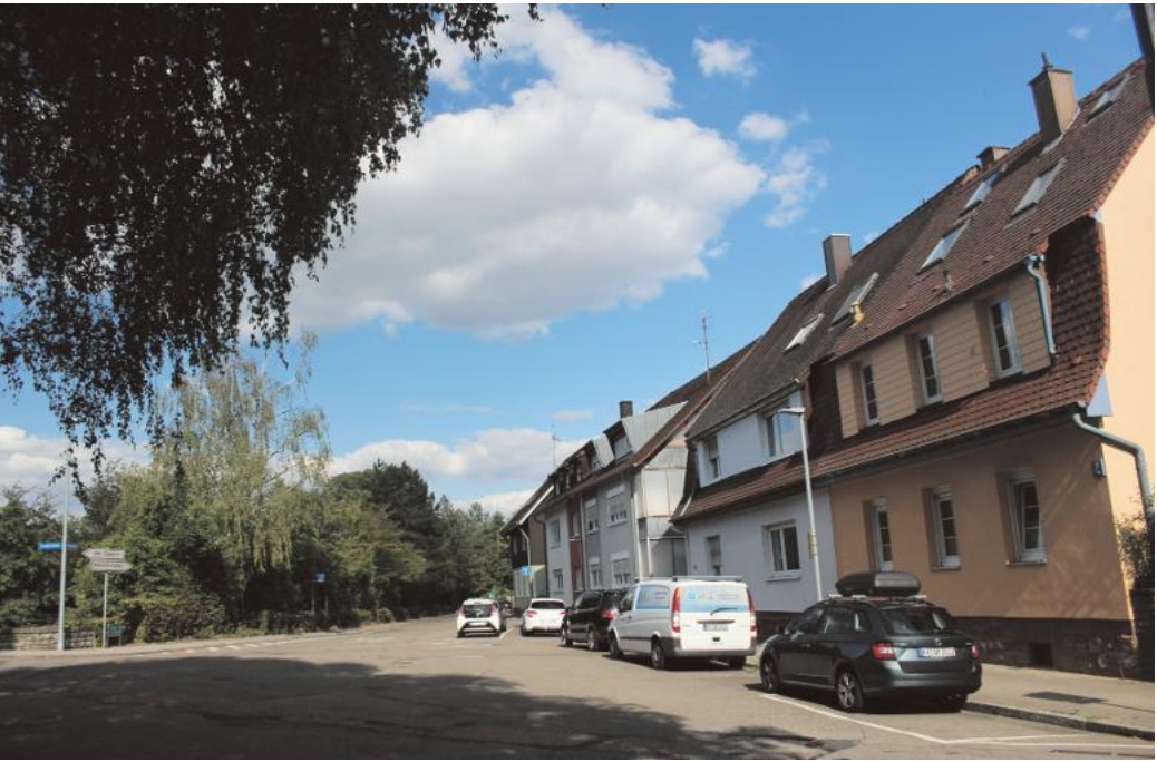
Vom Asphaltfeld zum geordneten Ortsraum: Neue Planung soll insgesamt sechs Parkplätze und mehr Grün an die Ecke Eisenbahn-/Oberausstraße bringen. Foto: Sven Scherz-Schade
