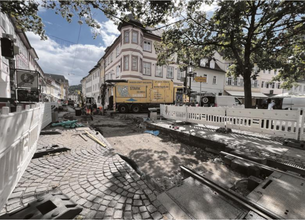
Wegen Gleisbauarbeiten für die Tramlinien 1 und 2 kommt es bis Ende November zu erheblichen Einschränkungen, Behinderungen und Fahrplanänderungen. Foto: kb.
