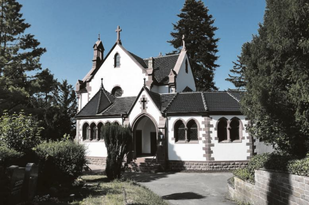
Die Kapelle des Bergfriedhofs wurde vor einigen Jahren aufwändig restauriert. Foto: Iris Treiber
