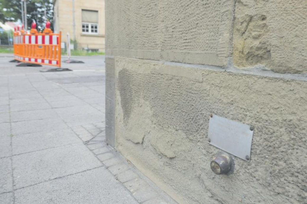
Die Entfernung zwischen dem Höhenfestpunkt am Gebäude Gymnasiumstraße 6a (vorne) und dem Höhenfestpunkt an der Ecke des Markgrafengymnasiums, derzeit hinter dem Bauzaun, beträgt etwa 26 Meter. Der Höhenunterschied beträgt genau 296 Millimeter. Foto: Iris Treiber
