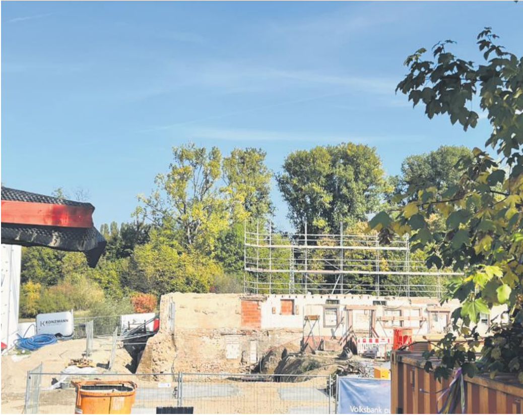
Zugegebenermaßen: Der heutige Anblick des ehemaligen Mühlengebäudes lässt den Ursprung nicht mehr erkennen. Foto: Eva-M. Ruf
