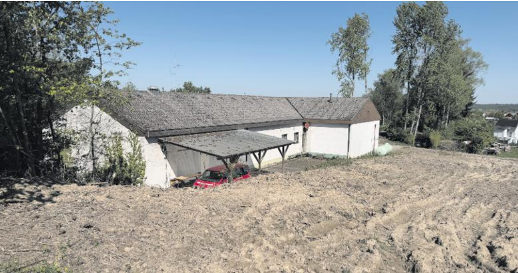
Der Weg ist geebnet: Die Erdarbeiten für das neue Feuerwehrgerätehaus in Langensteinbach haben dieser Tage begonnen. Foto: Archiv Gemeinde Karlsbad
